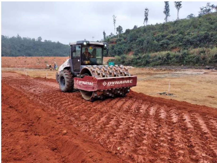
Trator e rolo compactador preparando mais uma camadas das 04-06-08 compactadas
