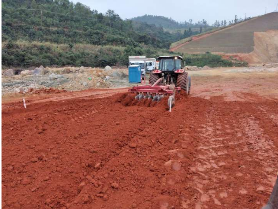
Trator patrol, grade de 32 discos, durante homogeneização do material, terra a ser compactada
