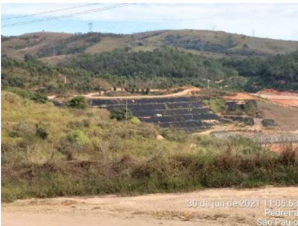
Foto 5 – Terra reservada e preservada da escavação, também utilizada para o curso de compactação de aterro experiemntal. Data: (30/06/2021).
