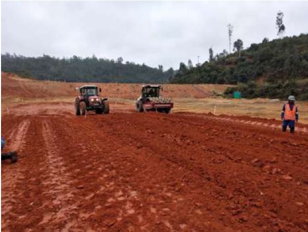
Foto 1 – Trabalhadores operam os tratores na preparação e compactação do aterro experimental. Data: (29/06/2021).
