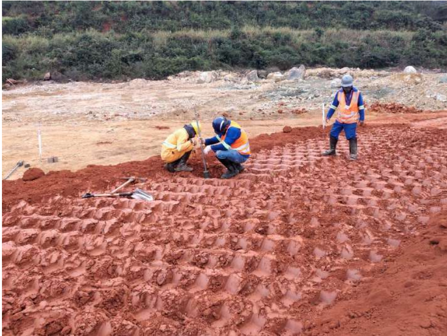
Passo a passo da captação de terra durante o Curso de Procedimentos Executivos para Aterros Compactados
