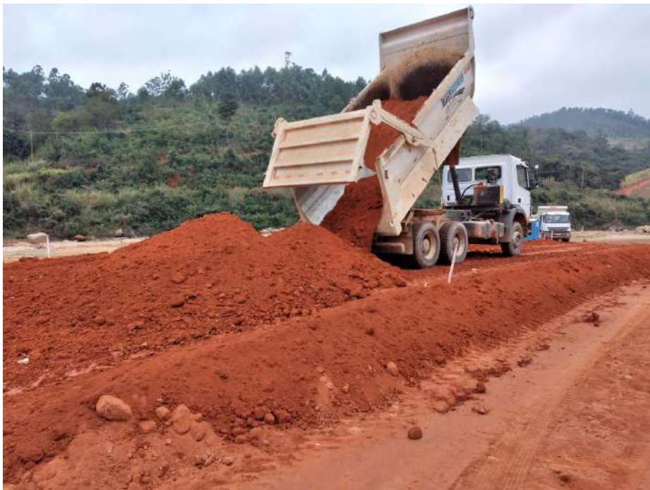
Terra sendo despejada para mais uma medição de camada a ser compactada
