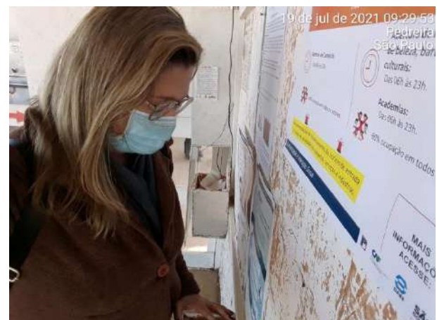
Foto 26 – Agente social e a caixa de comunicação instalada no canteiro de obras. (19/07/2021)
