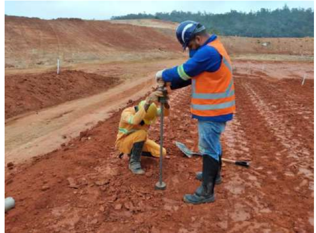
Foto 2 – Trabalhadores recebendo orientação do consultor para captar a terra necessária à medição da compactação em laboratório. Data: (29/06/2021).
