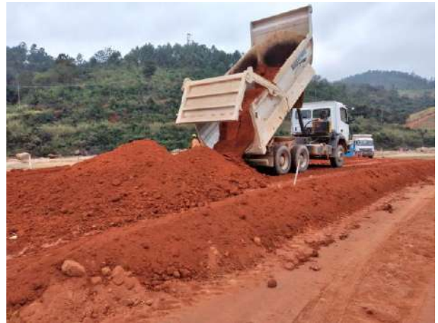
Foto 4 – Caminhões descarregam a terra reservada das escavações do empreendimento Barragem Pedreira para mais uma camada de teste do aterro experimental. Data: (29/06/2021).
